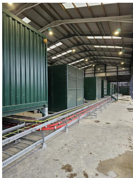
Site de construction – Crédits : Kyotherm
